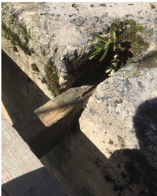
Bjelkeinnfesting på brokar landside.
