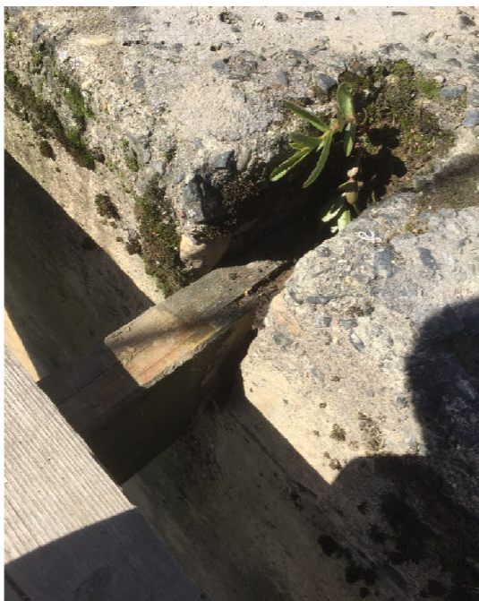
Bjelkeinnfesting på brokar landside.
