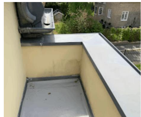
Lavt rekkverk, pent blikkenslagerarbeid.
