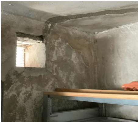
Bod under /ved garasje. Det er fuktmerker på vegg (saltutslag)
