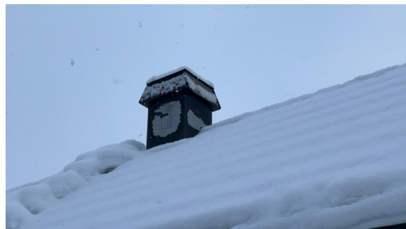
Flassing på takrenner/beslag.
