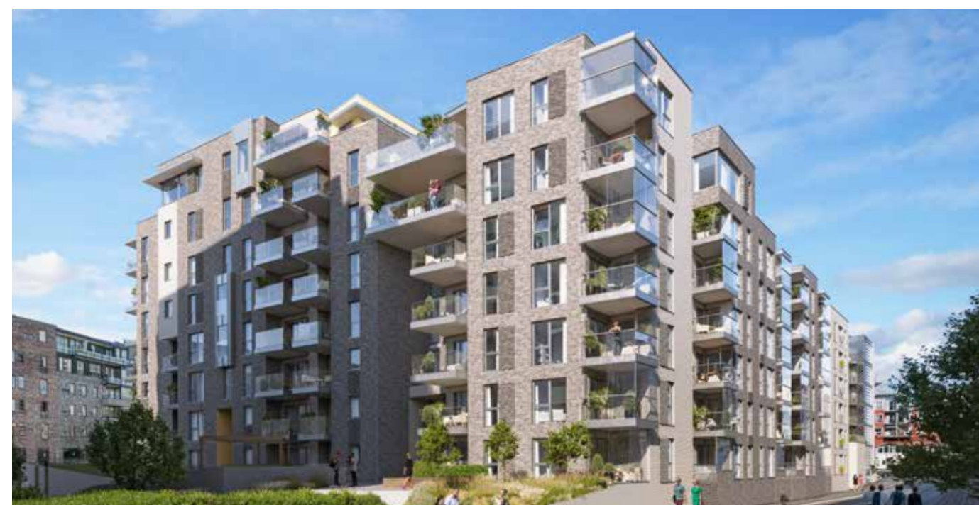
Bygg 2 sett fra Tangen vgs.
