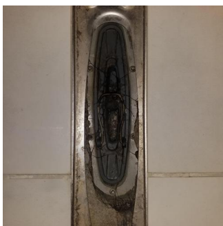
Vannnett sjikt / membran i gulv og vegger - Sluk bad i 6.etasje.
